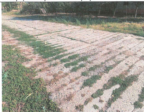
DS35- suprafata exfolita, iarba, fara acostamente dale tasate
