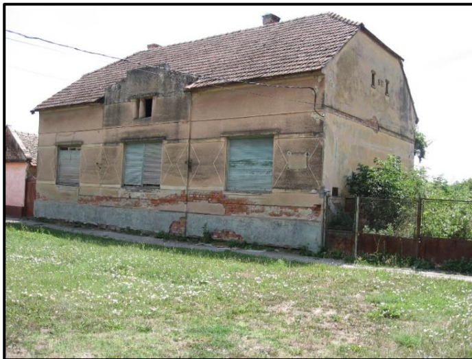
Foto 13 Clădirea dispensarului medical înainte de reabilitare (2017)
