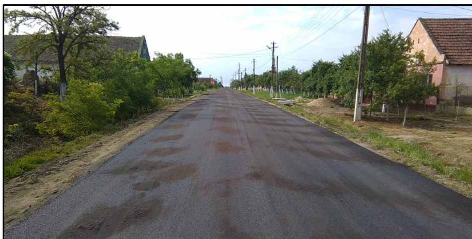
Foto 6. Drum asfaltat în Comuna Valcani, proiect finanțat din bugetul local în anul 2016.
