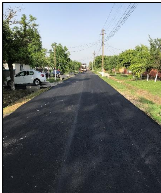
Foto 5 Lucrări de asfaltare în cadrul proiectului "Modernizare străzi în Comuna Valcani, jud. Timiș"; Sursa de finanțare: PNDL
