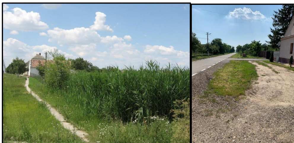
Foto 8. Stradă cu trotuar degradat și stradă fără trotuar
