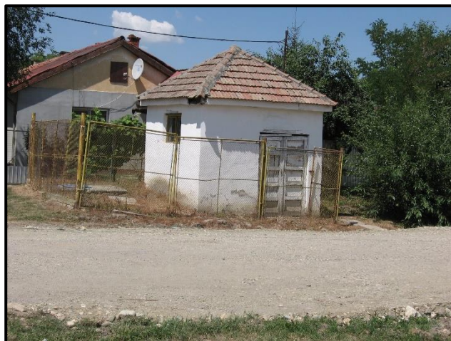
Foto 17. Forajul F 2, necesită lucrări de reabilitare
