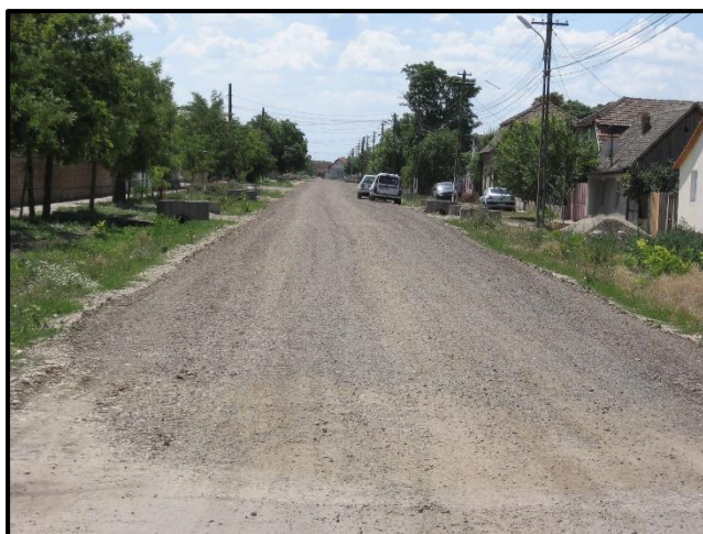
Foto 4 Lucrări de asfaltare în cadrul proiectului "Modernizare străzi în Comuna Valcani, jud. Timiș"; Sursa de finanțare: PNDL
