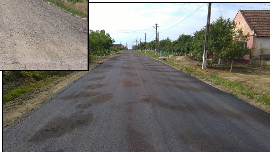
Foto 5. Drum asfaltat în Comuna Valcani, proiect finanțat din bugetul local în anul 2016.
