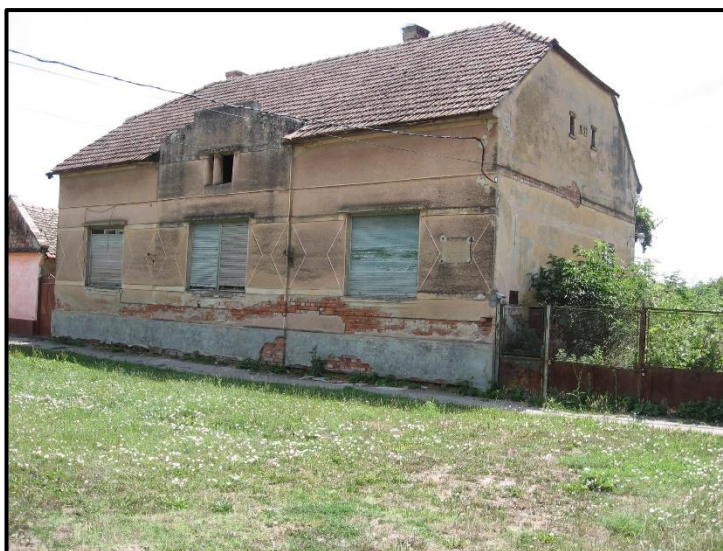
Foto 10. Clădirea vechiului dispensar, desființat în anul 2009, dar pentru reabilitarea căruia se caută surse de finanțare
