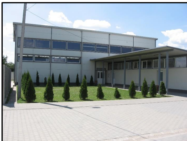
Foto 14. Sala de gimnastică; finalizată în anul 2015
